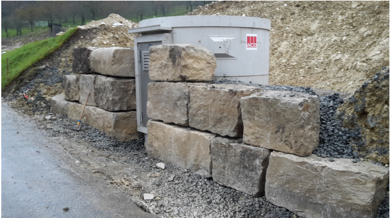
Abbildung: Stufenpumpwerk (STPW) Bärenwilerweg im Bau
